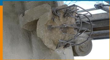
En algunos pináculos de esquina que presentaban grietas continuas de arriba hacia abajo fracturando la pieza, se han inyectado con lechadas de cal y posteriores cosidos de acero inoxidable previo sellado de las fisuras exteriores.
